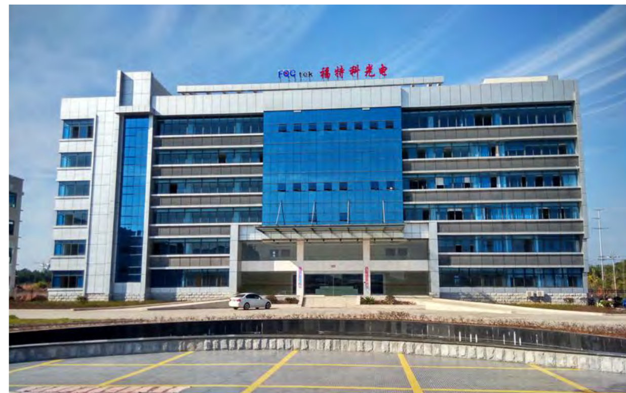
三明宁化生产基地 Sanming Ninghua Production Base
